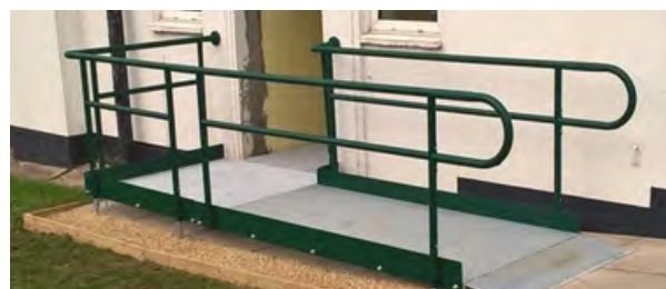
Ramp sy'n galluogi mynediad i ddefnyddiwr
